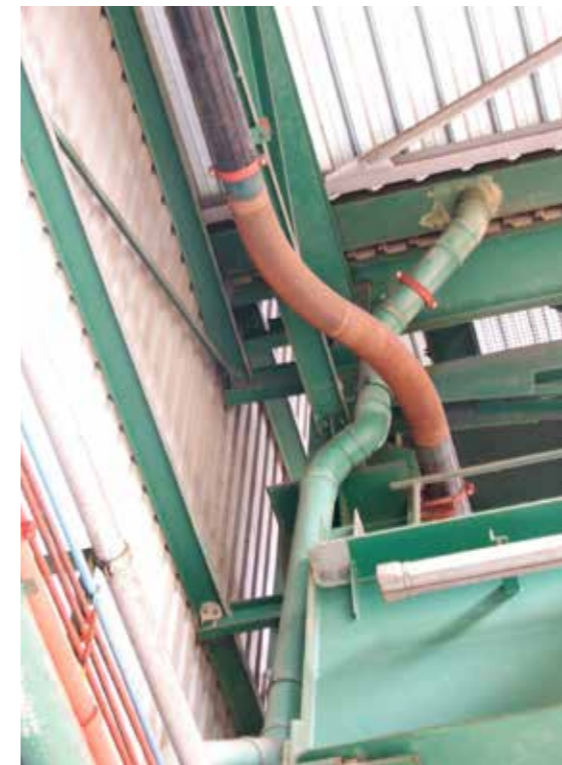
Vor der Sanierungsmaßnahme
