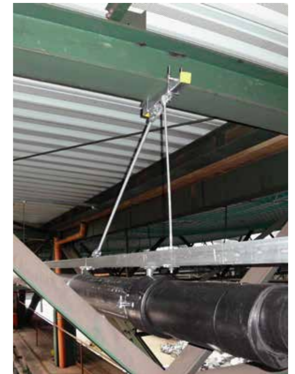
Nach der Sanierungsmaßnahme
